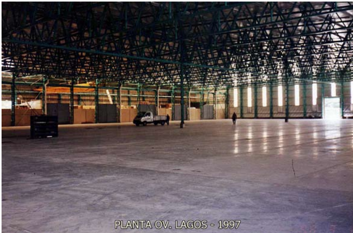
Interior de la actual planta de Briket en la Avenida Ovidio Lagos, antes de la instalación de las máquinas. 1997.
