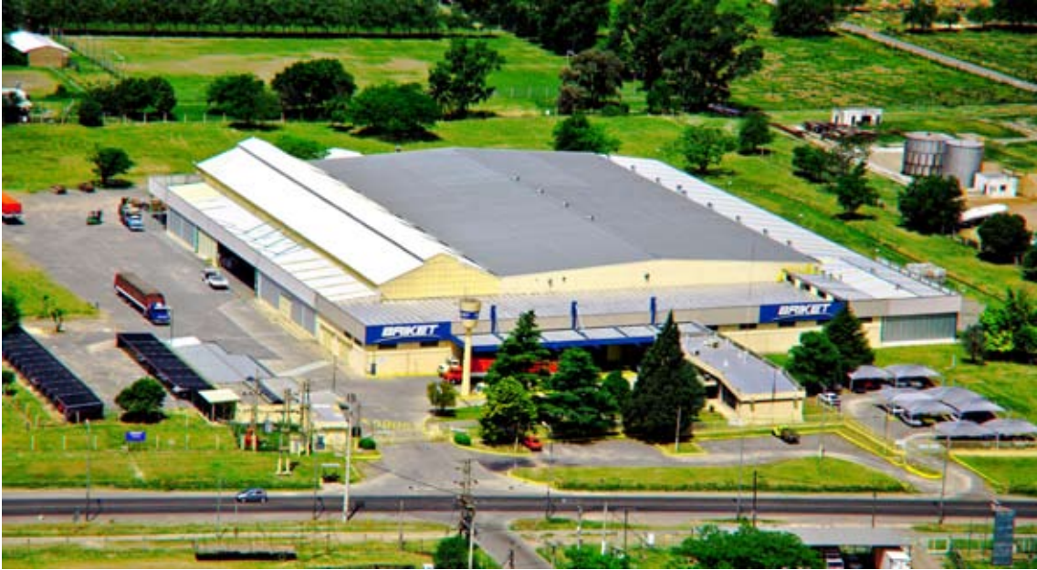
Vista aérea de la actual planta de Briket.
