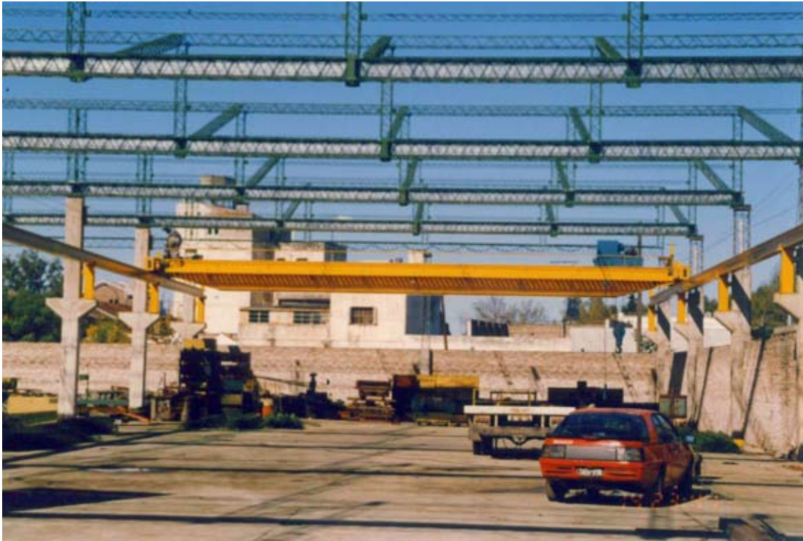
La construcción de las nuevas naves de la fábrica. 1988-1990.
