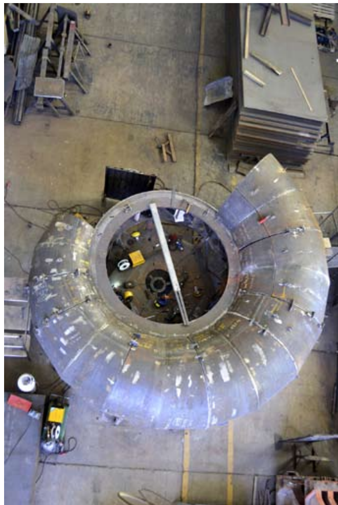
Fabricación de cámara espiral para turbina de la Central Hidroeléctrica Punta Negra. Provincia de San Juan.
