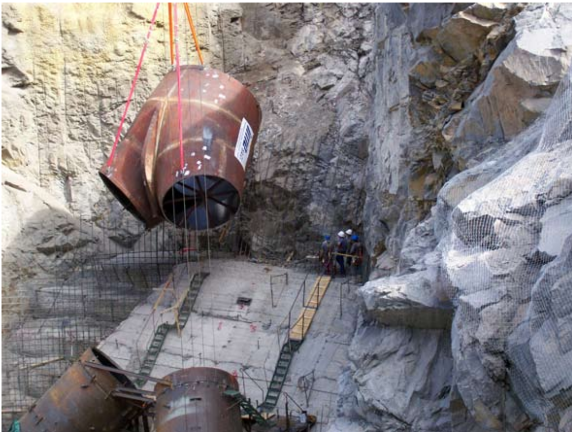
Montaje de tubería forzada en la Central Hidroeléctrica Caracoles. Provincia de San Juan.
