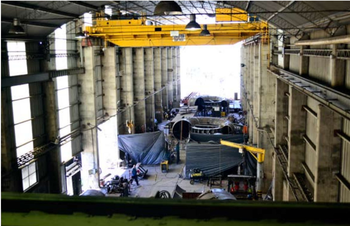
Nave Industrial de IME. Fabricación de Cámaras Espiral para la Central Hidroeléctrica Punta Negra. Provincia de San Juan.
