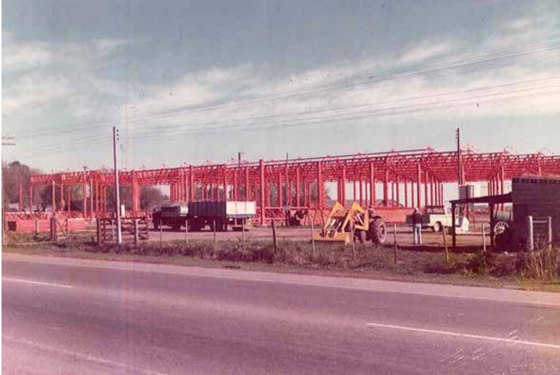
Armado de la estructura.
