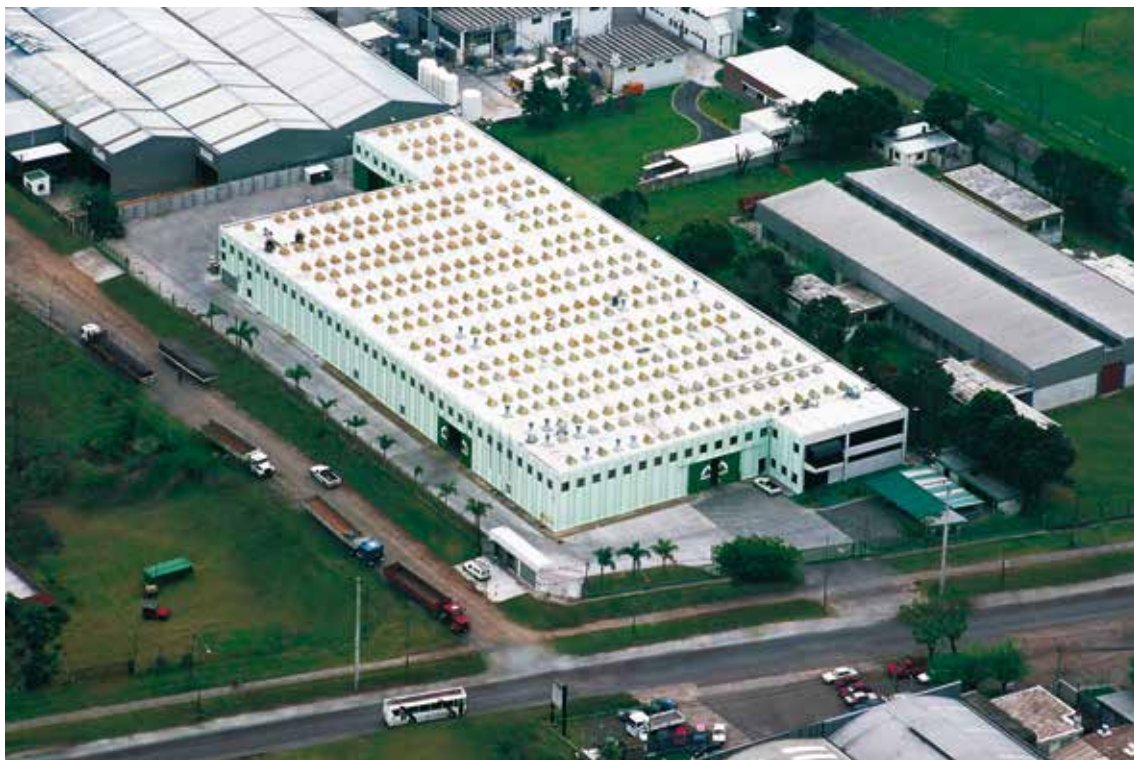
La Nave I de Metalbo.
