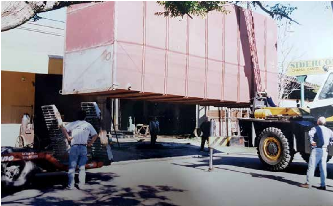
Tanque para tratamiento de efluentes industriales construido por Sidercon para la firma La Cristina S.R.L. Año 2000.
