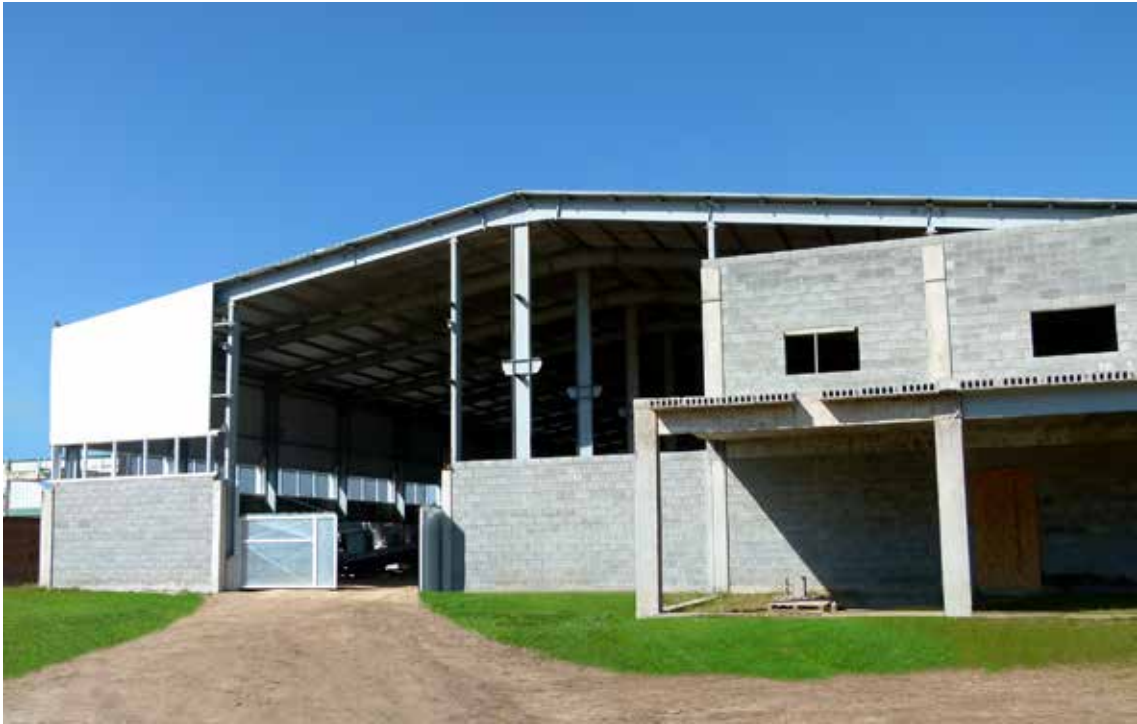
Construcción de la nueva planta.
