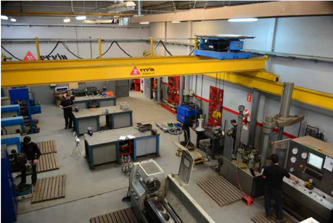
Taller de ensamble, reparación y calibrado de válvulas.
